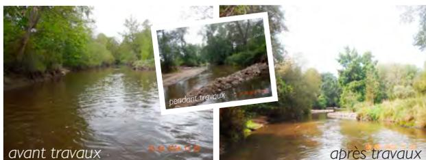
Les chantiers se sont ensuite poursuivis dans le Loiret à Sennely, sur le Cosson et un de ces affluents, le ruisseau de la Poustière. Il s'agit cette fois de travaux de recharge granulométrique visant à stopper le phénomène d'incision (enfoncement des cours d'eau) engagé sur les linéaires de travaux. Pour cela, des sédiments sont remis aux rivières. Ces sédiments proviennent des merlons disposés de part et d'autre des cours d'eau (sur les rives), créés lors des anciens curages.
